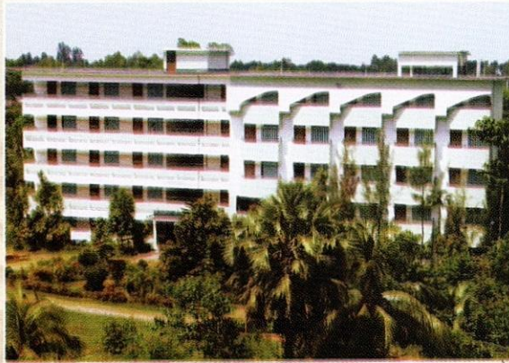
المبنى السكني للطالبات
